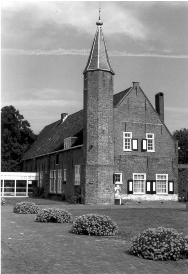
De voormalige kaatsbaan te Haarlem in zijn huidige vorm.
